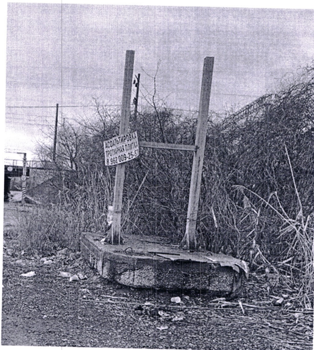
Фото нестационарного объекта
