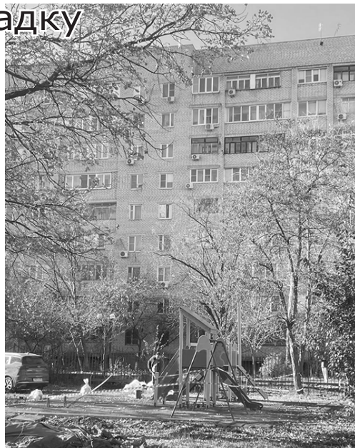
Строительно-ремонтные работы на детской площадке сквера «Дубрава»
