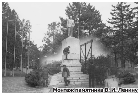
Монтаж памятника В. И. Ленину
